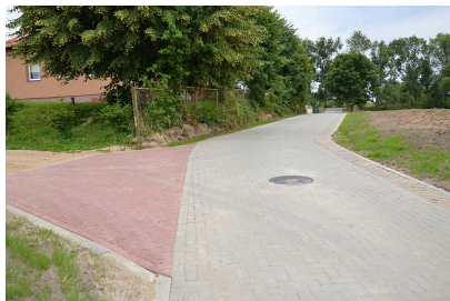
Ulica Jeziorna w Krzęcinie po modernizacji
