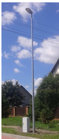
Modernizacja oświetlenia ulicznego
